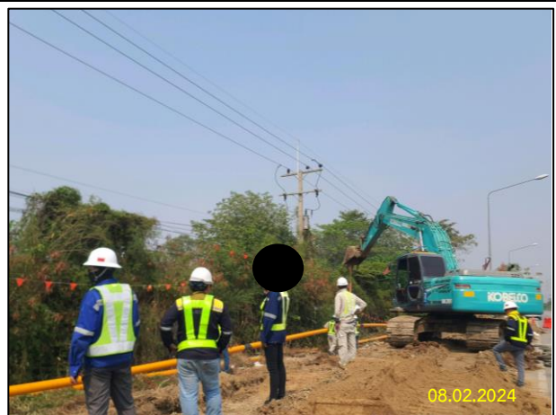
เจ้าหน้าที่ความปลอดภัยในการทำงานตรวจสอบไม่พบสิ่งกีดขวาง และผู้ปฏิบัติงานอยู่ในระยะที่อาจเกิดอันตรายกิจกรรมการยกท่อลงร่องชุด
