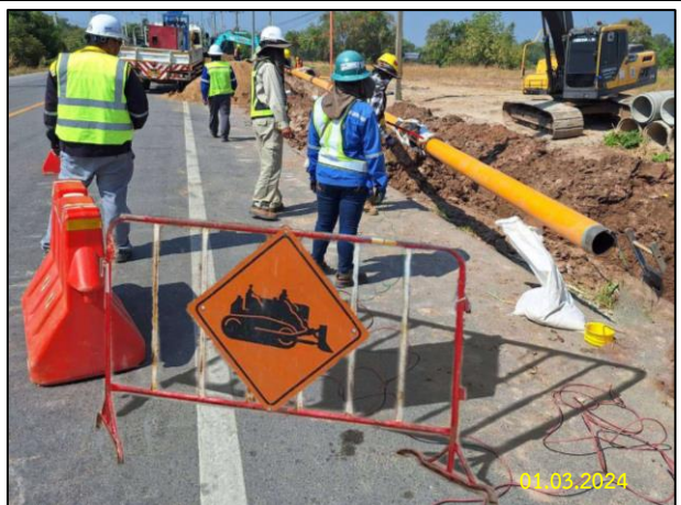
การกั้นเขตพื้นที่ก่อสร้าง พร้อมติดตั้งป้ายสัญญาณแสดงบริเวณที่ทำการขุด และเครื่องหมายเตือนแสดงเขตหวงห้ามที่อาจเกิดอันตราย ขณะรถแบ็คโฮกำลังปฏิบัติงาน
