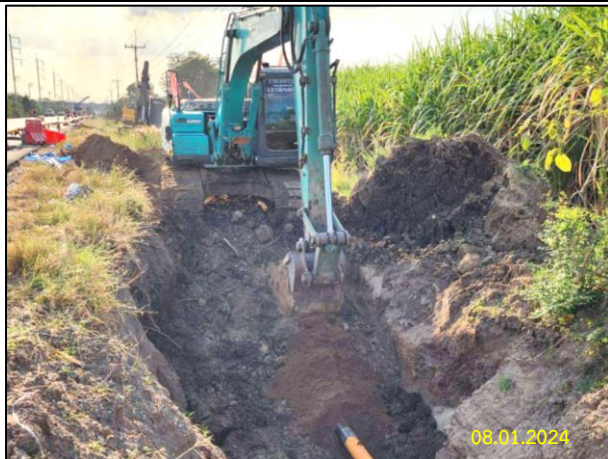
การเปิดพื้นที่ก่อสร้าง และการกลบท่อตันที่ภายหลังการวางท่อแล้วเสร็จ
