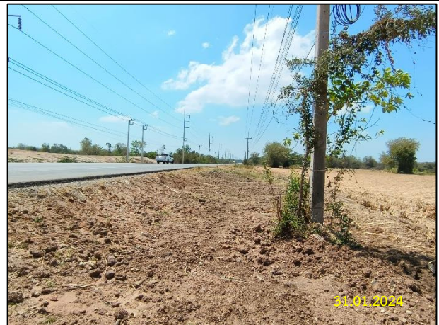
การเปิดพื้นที่ก่อสร้าง และการกลบท่อตันที่ภายหลังการวางท่อแล้วเสร็จ
