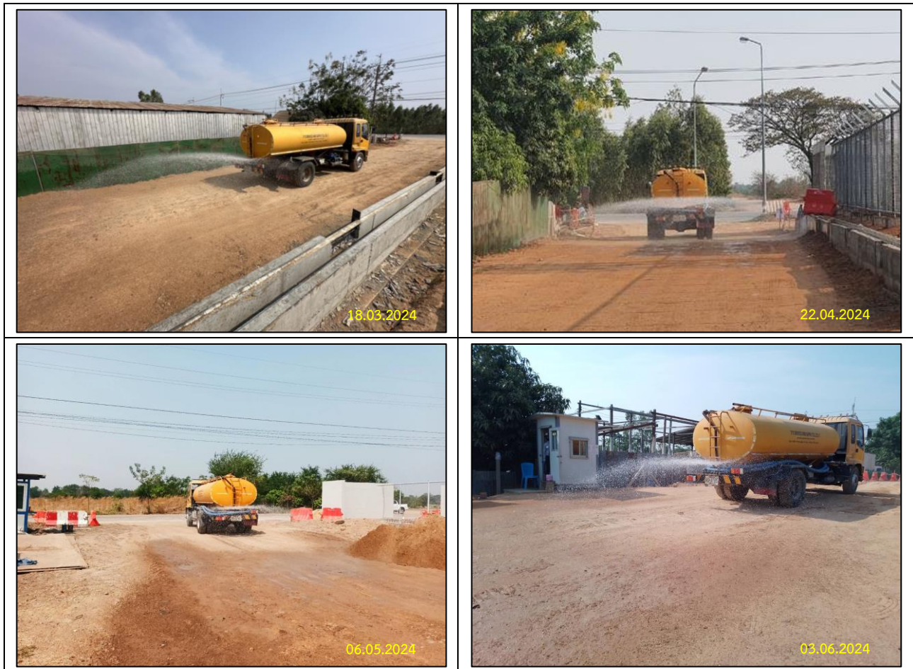
รูปที่ 2-3 การฉีดพรมน้ำบริเวณพื้นที่ก่อสร้างและเส้นทางคมนาคมในบริเวณใกล้เคียงพื้นที่ก่อสร้าง (ต่อ)
