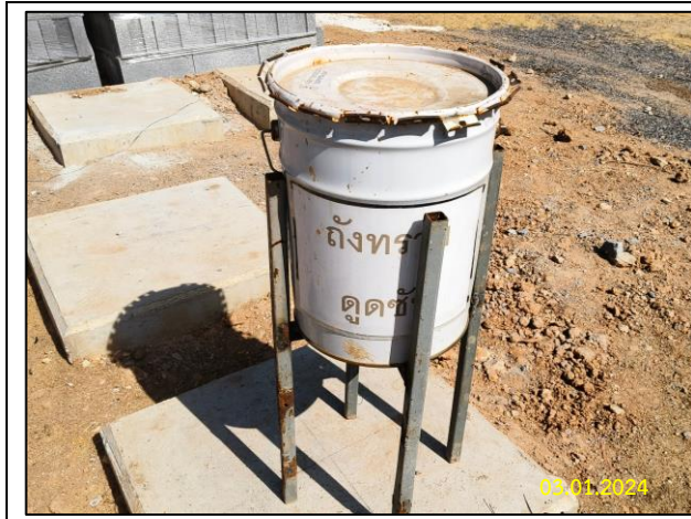
รูปที่ 2-12 การจัดเตรียมภาคเก็บและรองรับน้ำมัน พร้อมวัสดุดูดซับ (ต่อ)
