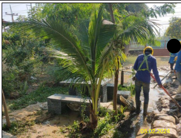
จ) การจัดเก็บโคลนโซเดียมเบนโทไนท์ที่รั่วไหลขึ้นในบริเวณพื้นที่ใกล้เคียง
