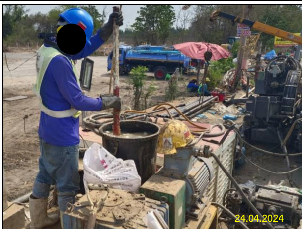
ก) การผสมโซเดียมเบนโทไนท์เพื่อใช้ในการเจาะลดให้พอดีกับปริมาณงานเจาะลด
