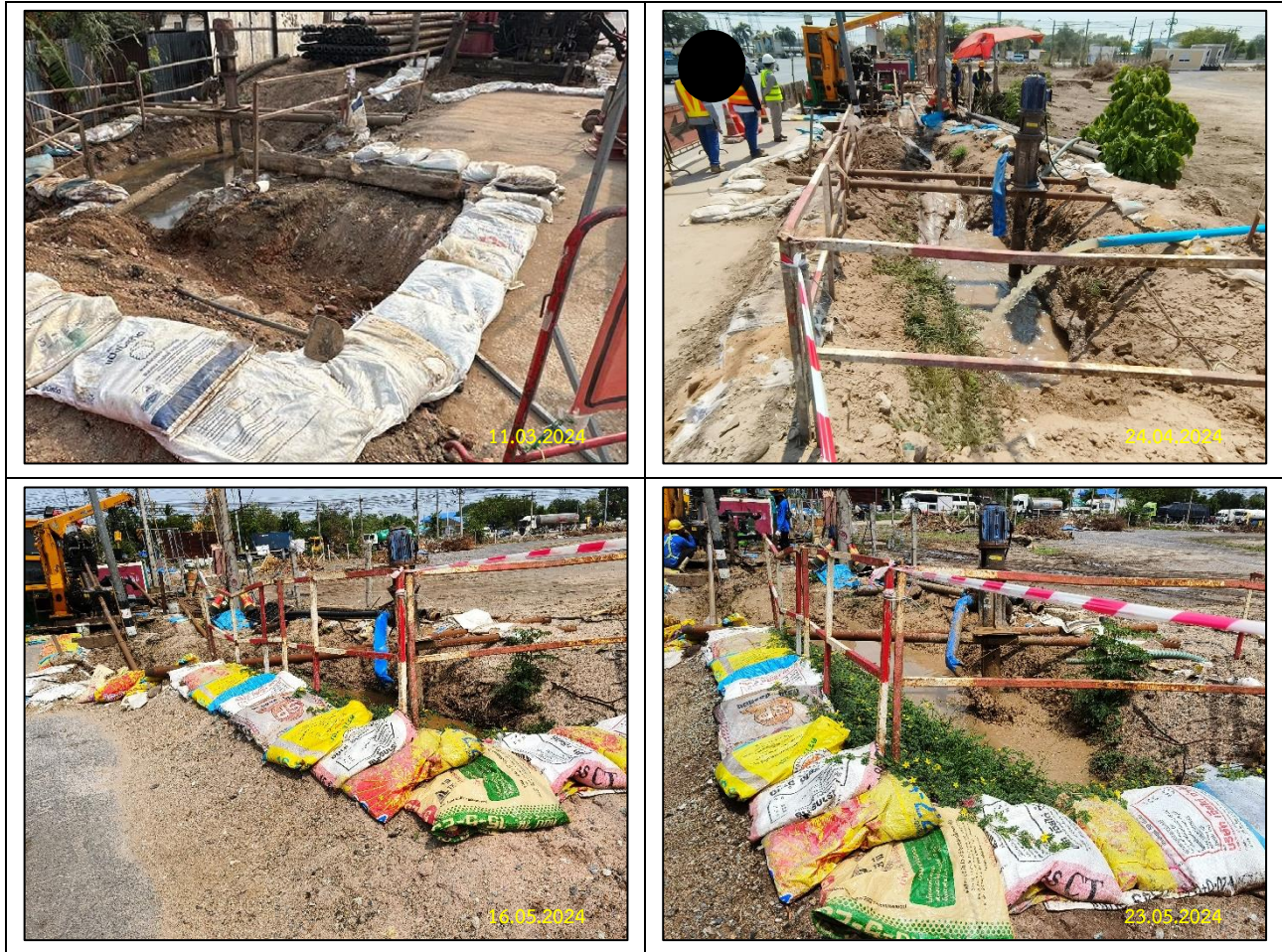
รูปที่ 2-10 การจัดวางถุงทรายหรือจัดทำคันดินกั้นรอบพื้นที่บ่อรับ-บ่อส่ง (ต่อ)
