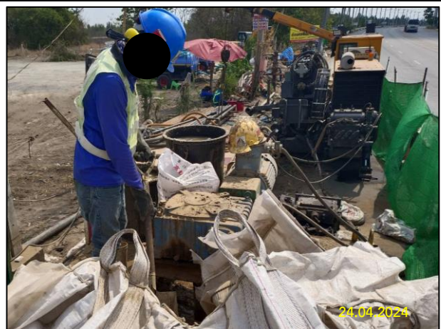
ก) การผสมโซเดียมเบนโทไนท์เพื่อใช้ในการเจาะลดให้พอดีกับปริมาณงานเจาะลด
