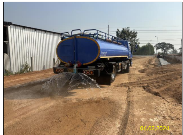
รูปที่ 2-3 การฉีดพรมน้ำบริเวณพื้นที่ก่อสร้างและเส้นทางคมนาคมในบริเวณใกล้เคียงพื้นที่ก่อสร้าง
