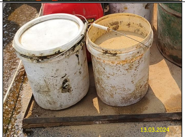
รูปที่ 2-12 การจัดเตรียมถาดเก็บและรองรับน้ำมัน พร้อมวัสดุดูดซับ
