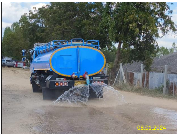
รูปที่ 2-3 การฉีดพรมน้ำบริเวณพื้นที่ก่อสร้างและเส้นทางคมนาคมในบริเวณใกล้เคียงพื้นที่ก่อสร้าง
