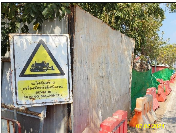
การกั้นเขตพื้นที่ก่อสร้าง พร้อมติดตั้งป้ายสัญญาณแสดงบริเวณที่ทำการขุด และเครื่องหมายเตือนแสดงเขตหวงห้ามที่อาจเกิดอันตราย ขณะรถแบ็คโฮกำลังปฏิบัติงาน
